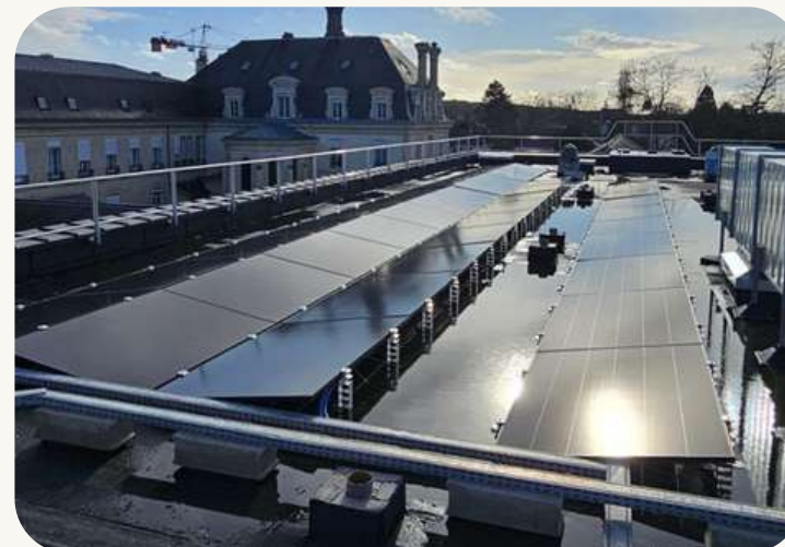
Installation de panneaux photovoltaïques par GED SAS
